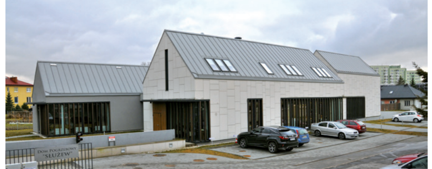
Obecna siedziba - murowana
